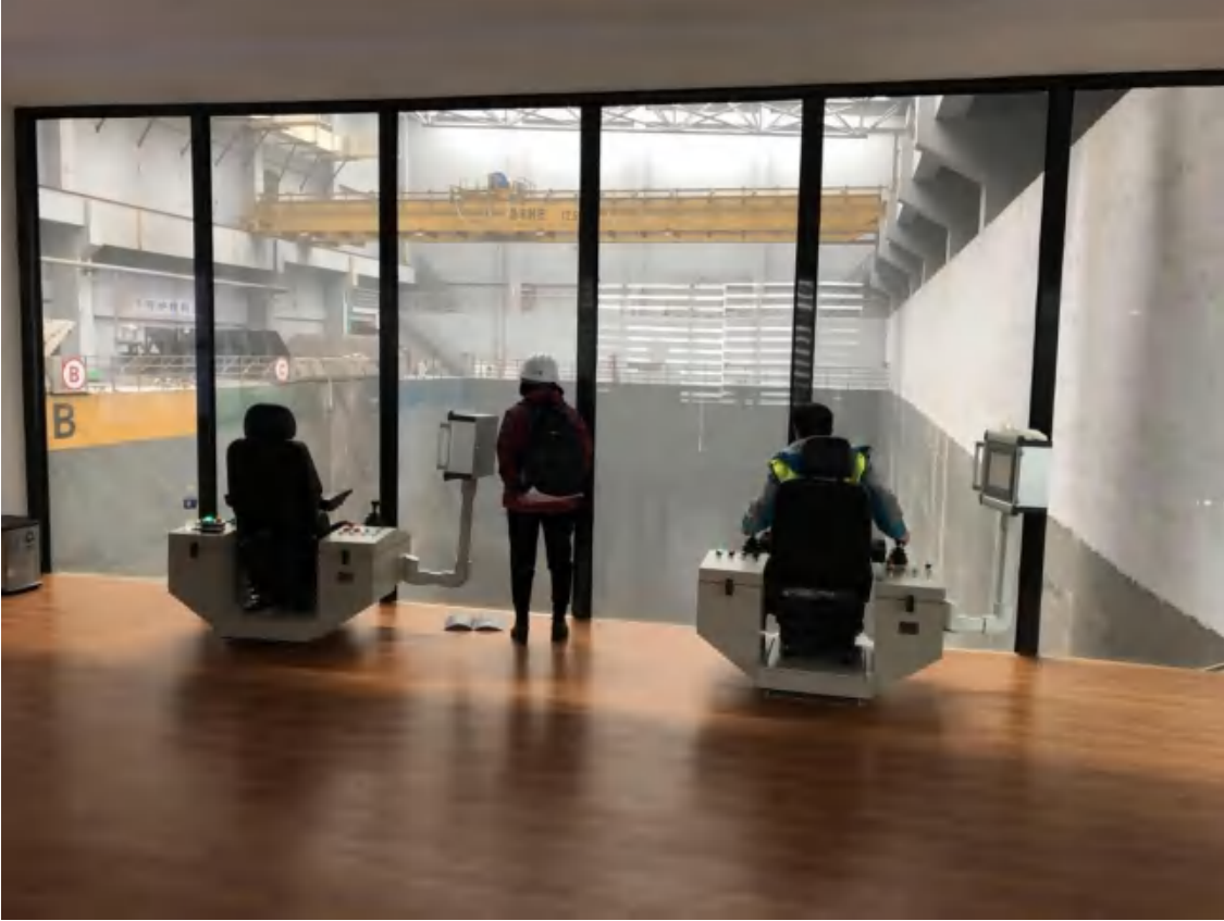
图 2.4-6 垃圾吊控制室
