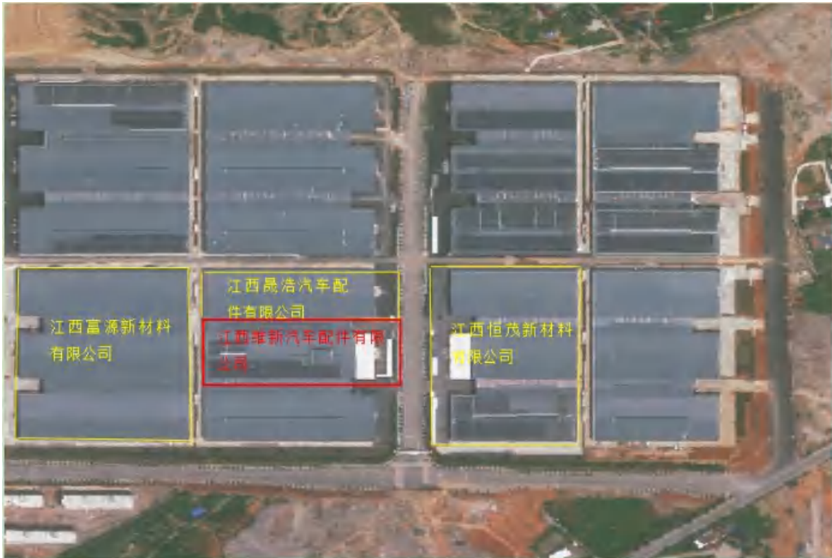
图 2.2-2 项目厂房周边情况图
