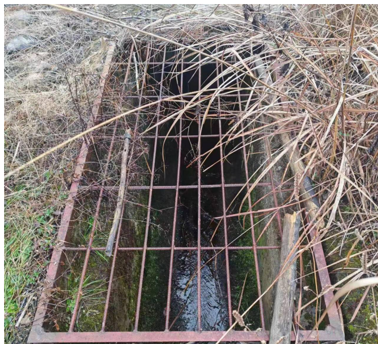
图 2.6-3 尾矿库内排水斜槽进水口
