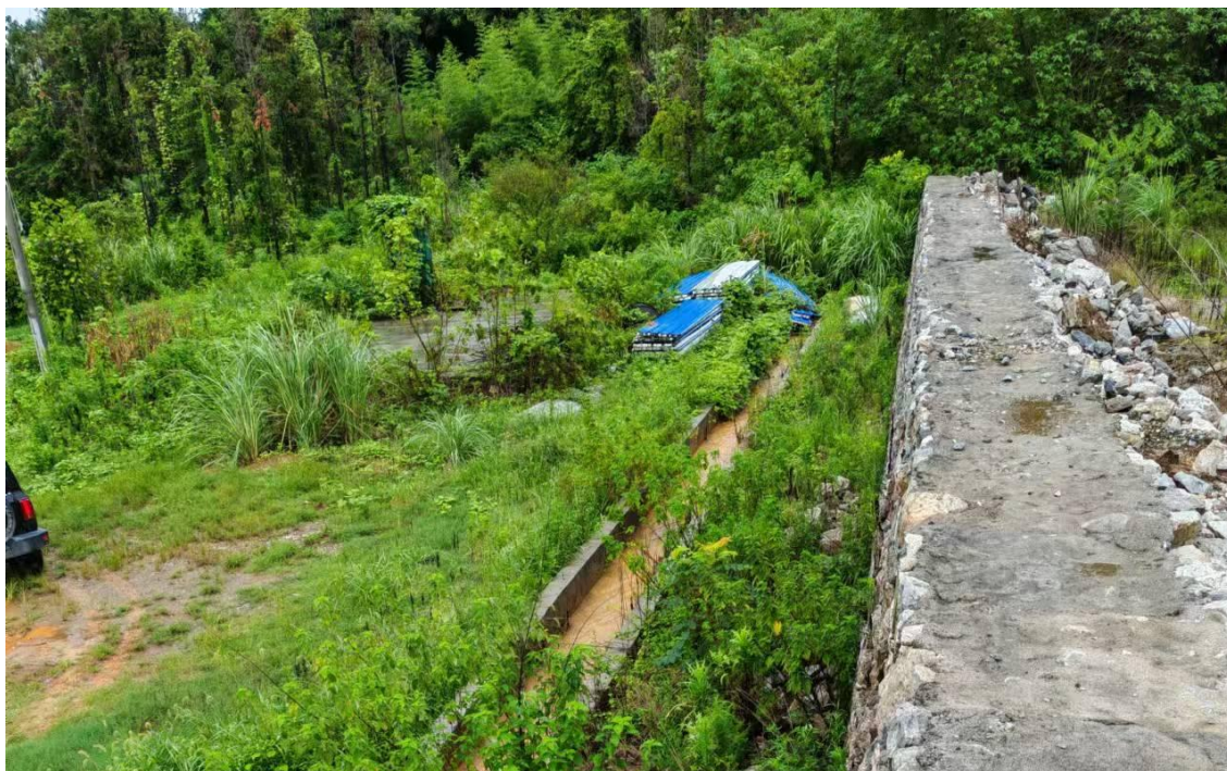
图 2-4 排土场拦渣坝与截排水沟现状图
