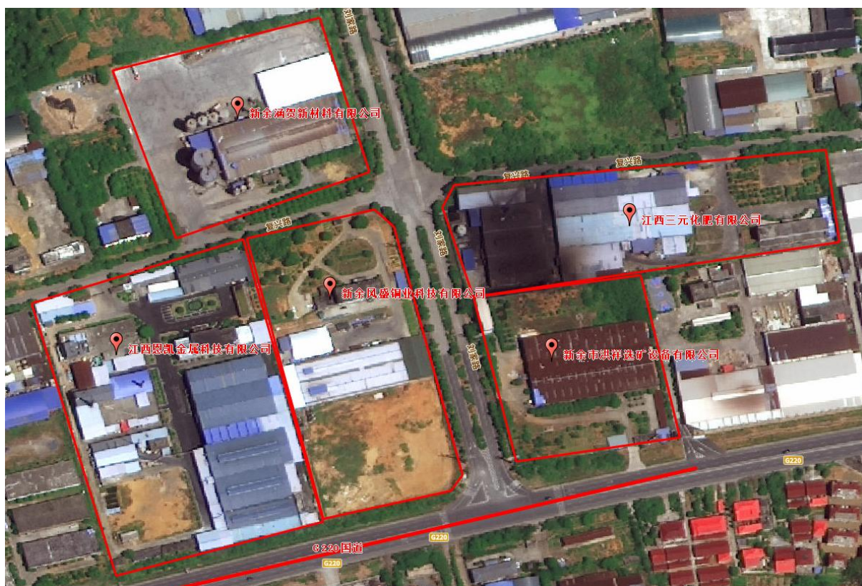
图 2.2-2 项目厂房周边情况图
